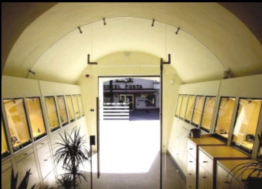
Glaselemente, punktgenau im Rundbogen, Ladeneingangsbereich, Klausen
